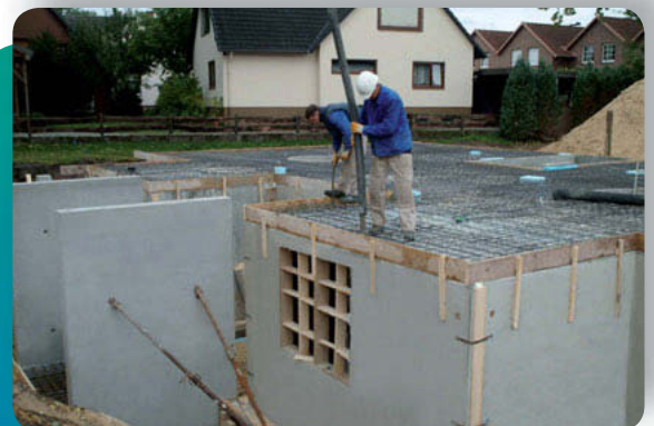
Betonieren
